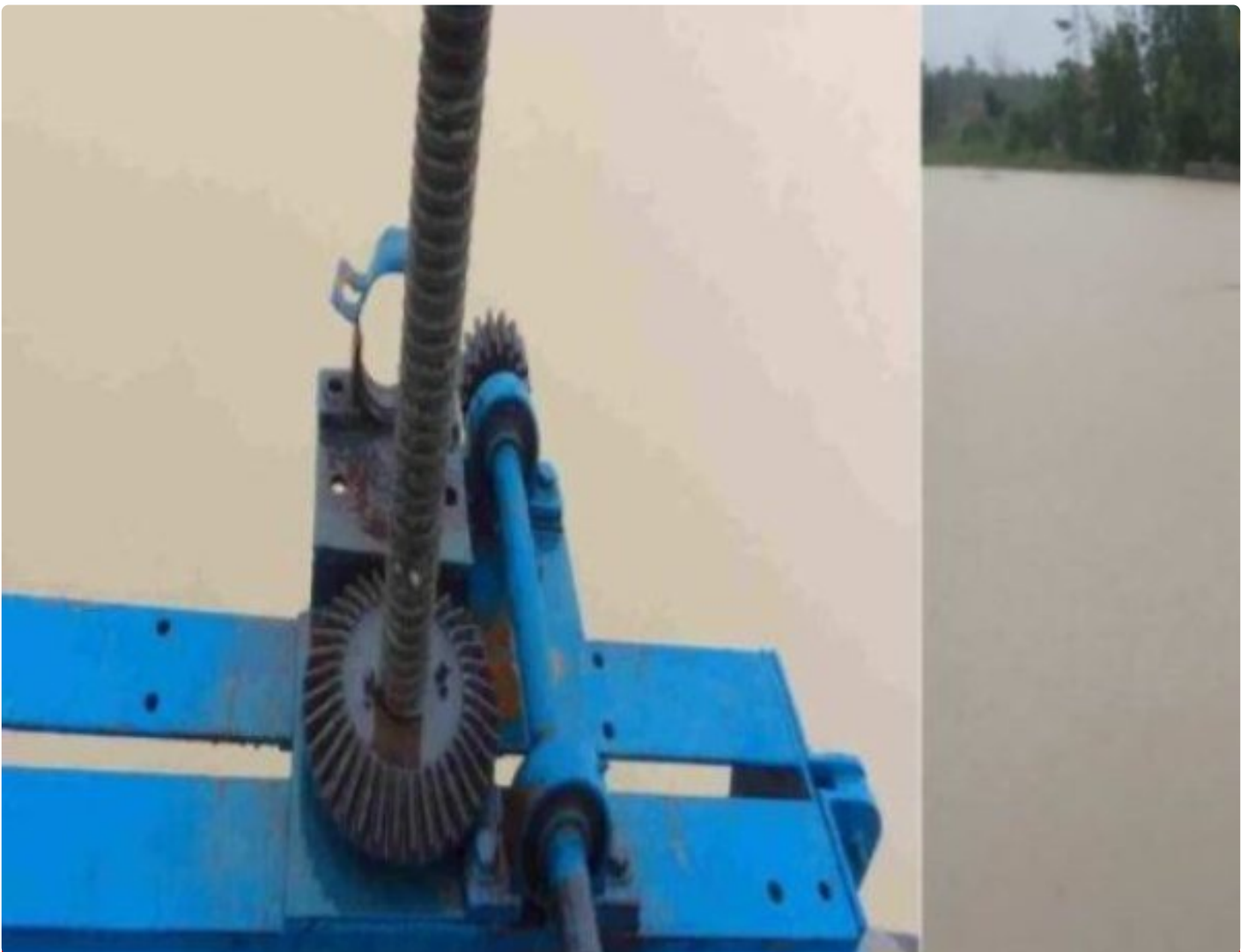
Pintu air Albaret Simpang Mesuji
